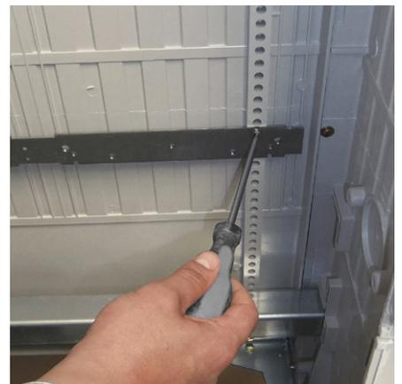
3. Stirnteile oben und unten jeweils mit 2 Senkschrauben M6 auf die Befestigungsschiene montieren.
