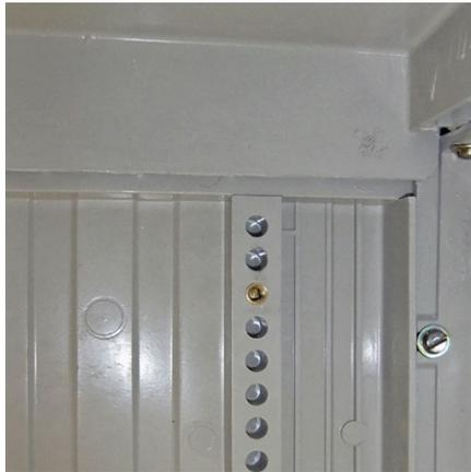
2. Schienen oben und unten jeweils mit 2 Senkschrauben M6 an der Rückwand befestigen.
