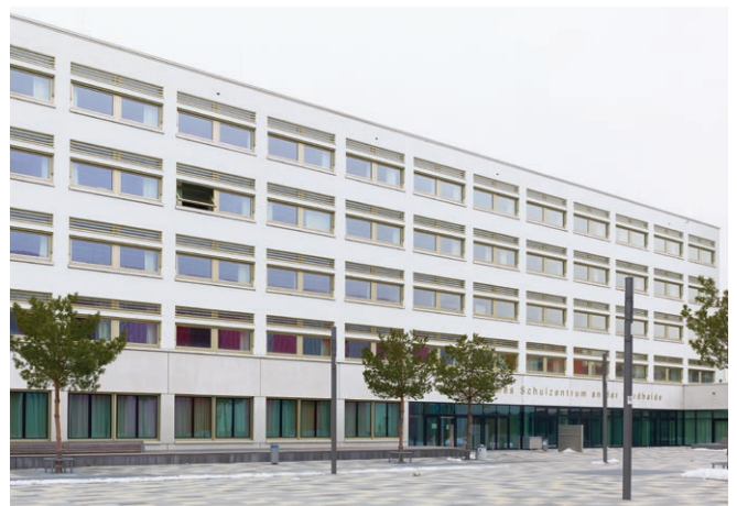
BOS / FOS Schule Nordheide, München, Fertigstellung 2017, Erschließung der Klassenräume mit Brüstungskanälen und Mediensäulen.
