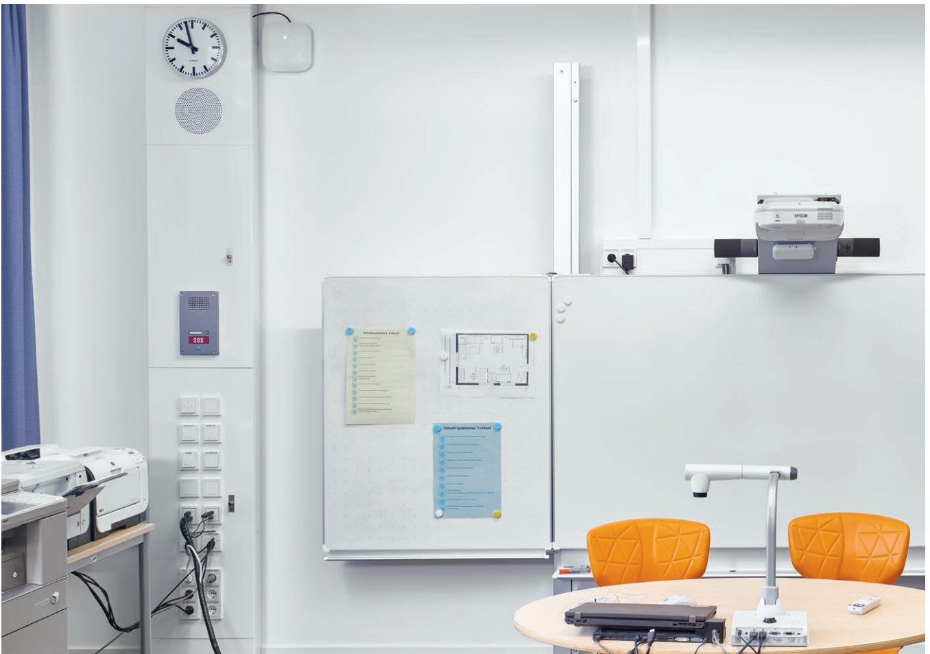
Realschule Meindlstraße, München, Neubau 2016, Erschließung der Klassenräume und des Pausenbereiches mit Mediensäulen und Stahlblech-Brüstungskanälen, Anbindung der PackPost-Säule direkt über das Unterflurssystem.
