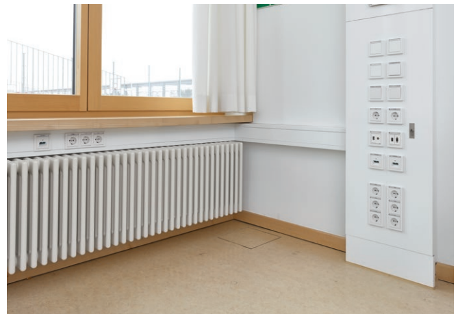
Leitungsführung im EDV-Raum der Grund- und Mittelschule Zolling mit Brüstungskanal und Systemeinsbauten (oben).
