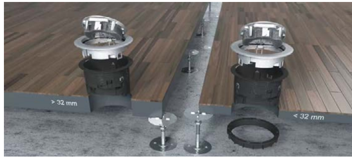
Einbau in Hohlboden
