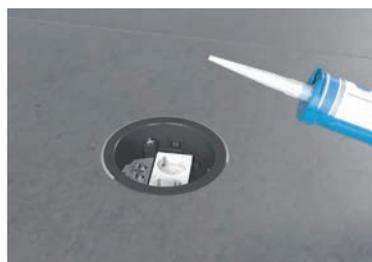
Mittels Silikonfuge wird die Dose abgedichtet.
