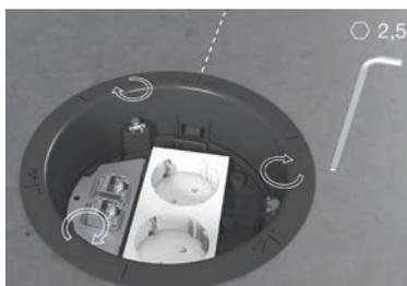
Mittels eines Inbusschlüssels wird die Installationsdose befestigt.
