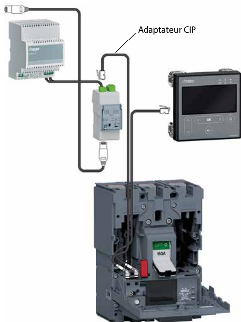
Anschluss des Kommunikationsmoduls
