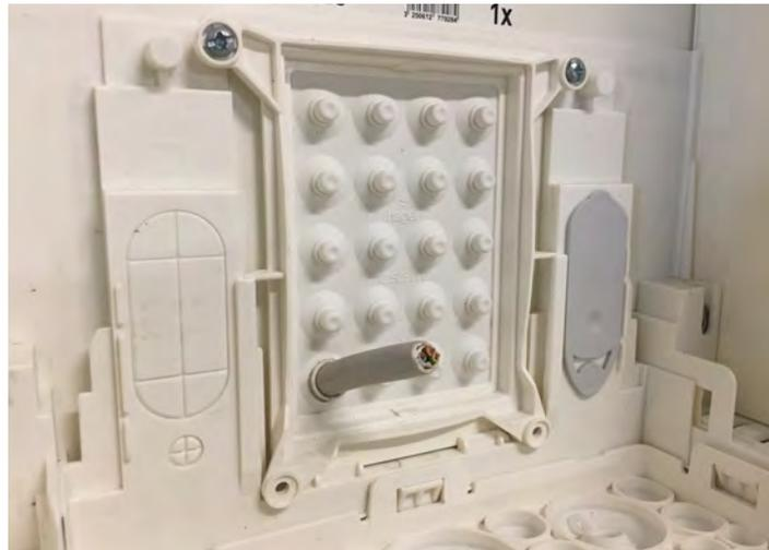
An Schrankrückseite montierter staubdichter Flansch FZ428
