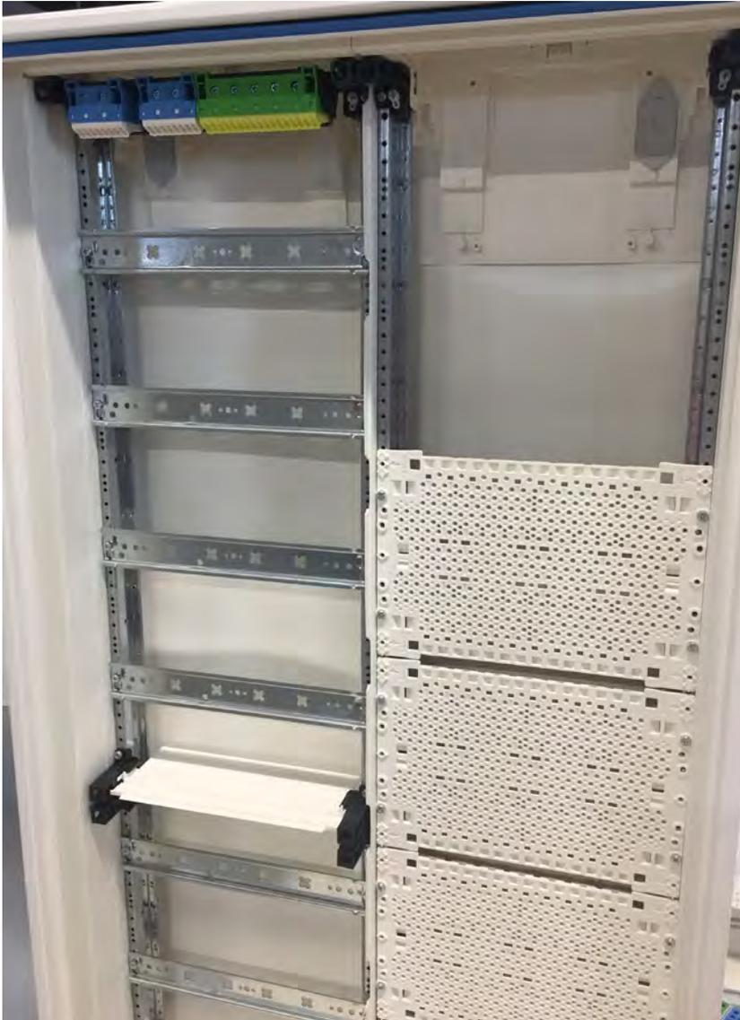
Schrank mit montierten Abschottungen
