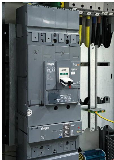
Palier de puissance et réglage de la protection Réglage Irth du disjoncteur de branchement (AGCP)
