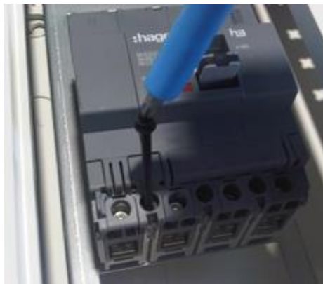
Fixation du disjoncteur boîtier moulé sur plaque métallique avec les vis M4 fournies
