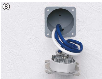
8 Kabelreserve eindrehen und Dose einbauen.
