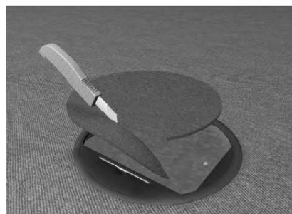
Corte o piso com as dimensões da tampa.
