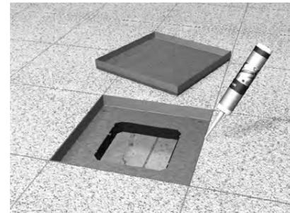
Coloque silicone entre o piso e a extremidade da caixa.
