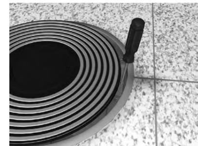
Para abrir a tampa, introduza uma chave de fendas até sentir pressão, posteriormente faça um movimento basculante para a retirar.
