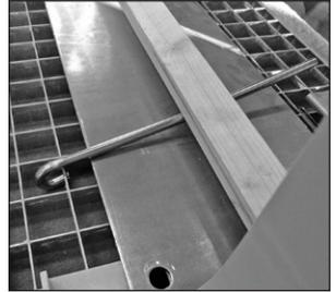
Klemmbügelhalter im mittleren Schwenkbereich des Klemmbügels von oben in den Bodenrost eindrücken. Seitlicher Ausschnitt zeigt zum Klemmbügel.
