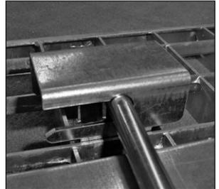
Bei zwei Klemmbügeln sind diese über die Breite der Bodenplatte zu verteilen.
