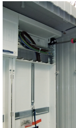
Zählerfeld oben und unten mit 2 x M5 anschrauben. Alle Schienen sind abzudecken!
