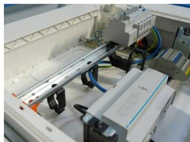
Esempio di montaggio con profondità di incasso elevata (quadri da equipaggiare)
