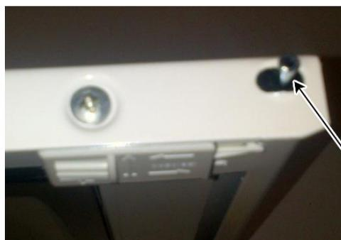
Le cerniere sono dotate di una piccola guarnizione sul perno di metallo, per impedire che l'acqua entri nel quadro e garantire così il grado di protezione IPx1.
