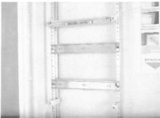
3. Bauteile (Hutschienen, Montageplatten, usw.) mittig zwischen die Stecktürme montieren.
