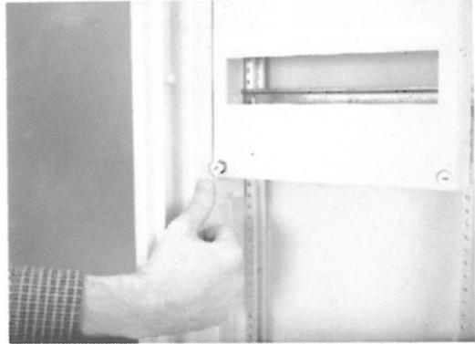
4. Haube auf Stecktürme setzen und Schnellverschlußbolzen eindrücken.
