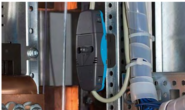
Punktsensoren mit Befestigungsclip SPBCLPS im 25-mm-Raster des Traggerüsts montiert
