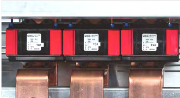
Schutzwandler vor dem Leistungsschalter der Einspeisung
