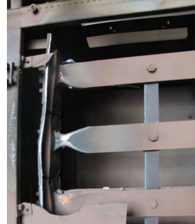
Erheblicher Schaden in Anlage mit hohen Folgekosten nach einem Störlichtbogen.
