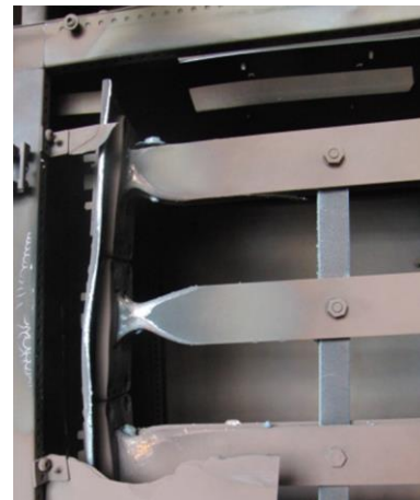
Lourds dommages sur l'installation avec coûts induits importants à la suite d'un arc électrique parasite
