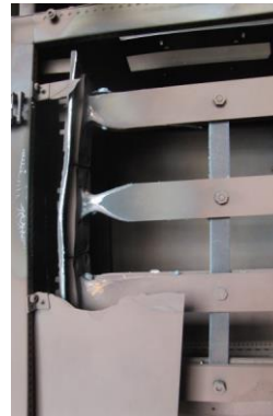
Erheblicher Schaden in der Anlage mit hohen Folgekosten nach einem Störlichtbogen.
