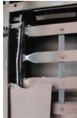
Lourds dommages sur l'installation avec coûts induits importants à la suite d'un arc électrique parasite.
