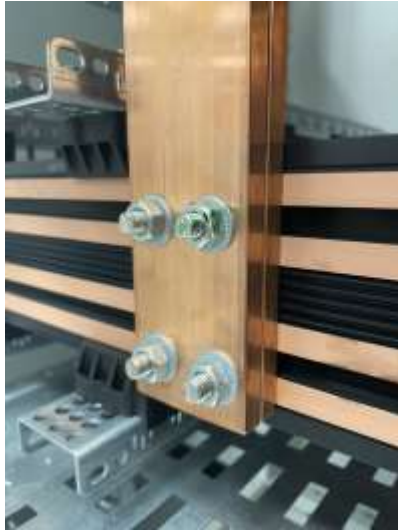
Esempio di collegamento fino a 1600 A
