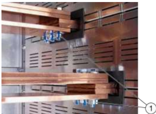
Przykładowe oznaczenie połączeń śrubowych
