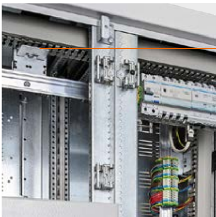
Halterung für die Montage eines Kabel- kanals
