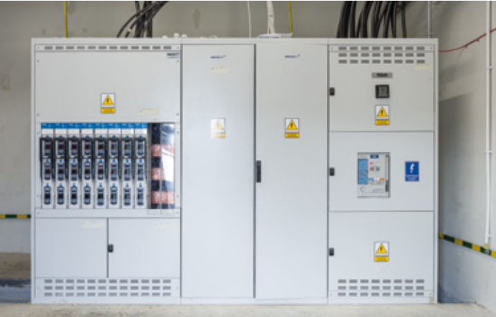
Hala logistyczna, Bielany Wrocławskie
