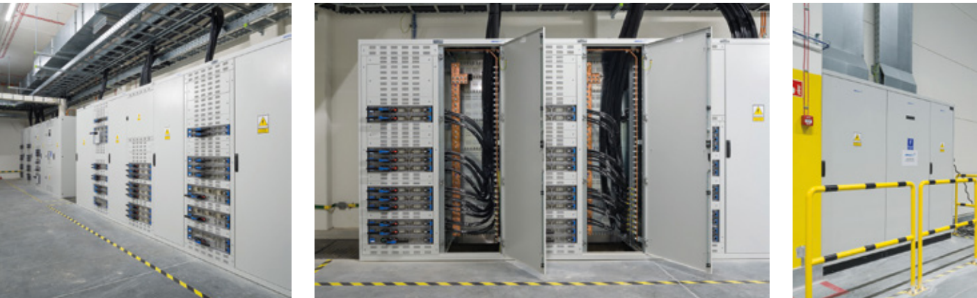
Hala logistyczna, Pawlikowice
