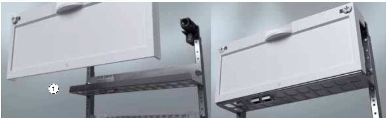
Einbau der Patchpanel-Abdeckung mit 2 Turmoberteilen
