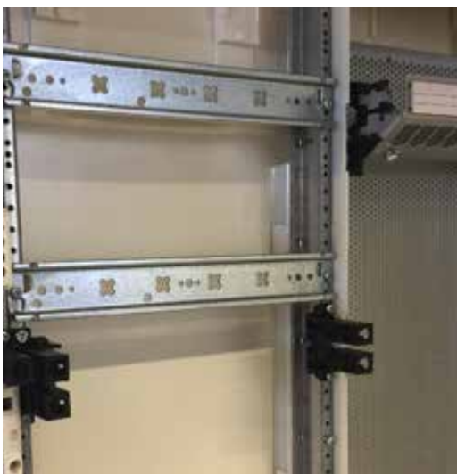
Aussparungen in der Mitte für den Einbau von Doppelturm UZ04A1
