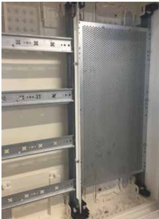
Einbau von UZ40F1 in Feldverteiler AP Größe 42 : Montage von vorne
