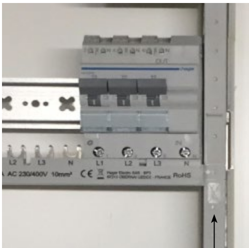
Abschottung UZx0F2 auch kompatibel zu Phasenschiene vertikal KCL...
