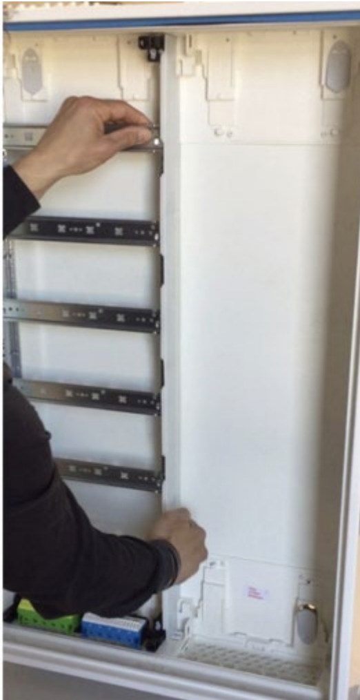
Einbau von UZ60F2 in Feldverteiler AP Größe 62: schnelles Einrasten von der Seite
