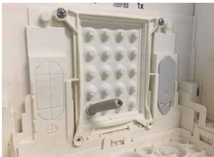
An Schrankrückseite montierter staubdichter Flansch FZ428
